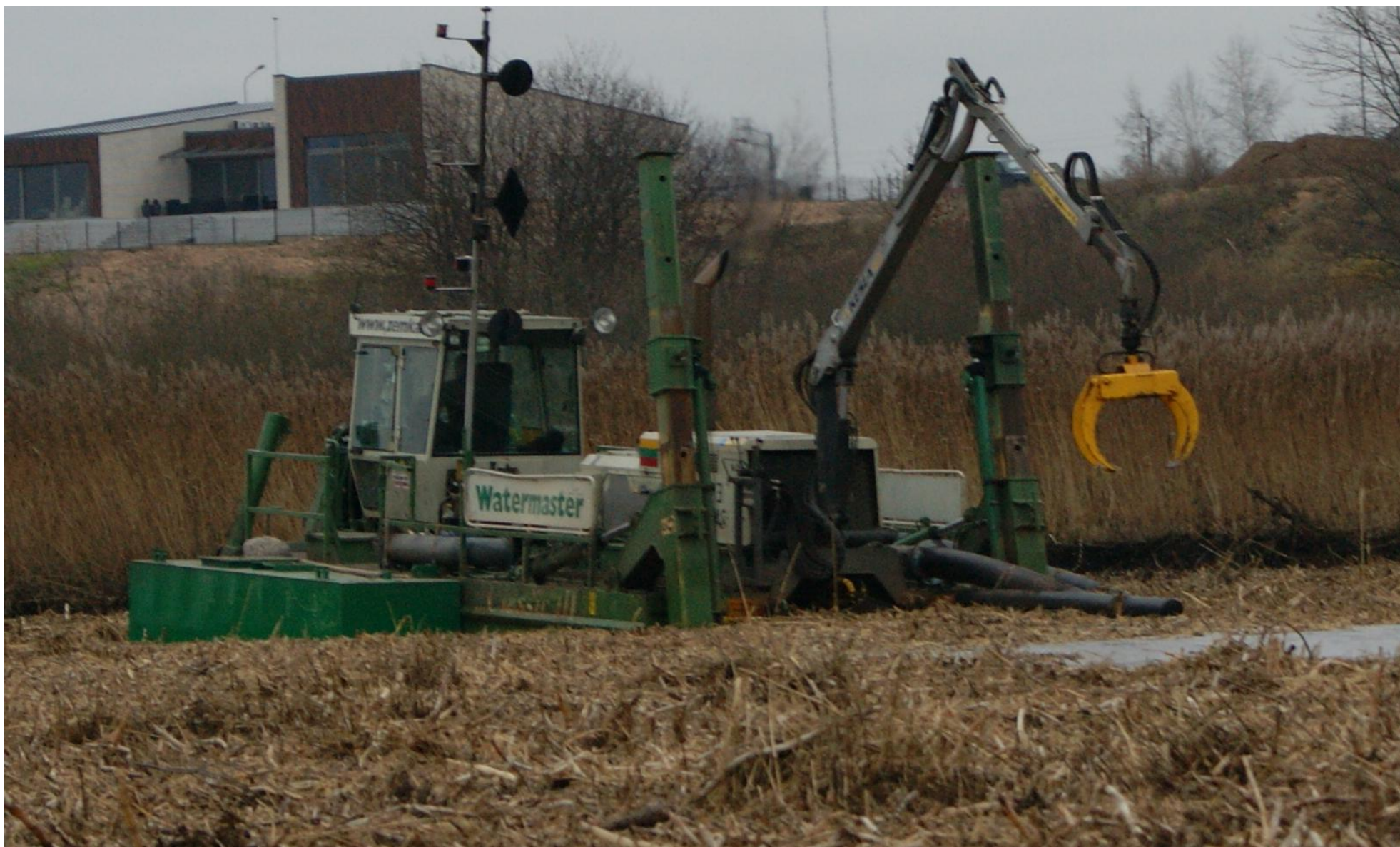
5 pav. Talkšos ežero šiaurinės dalies valymas žemsiurbe 2011 m. spalio- gruodžio mėn.
