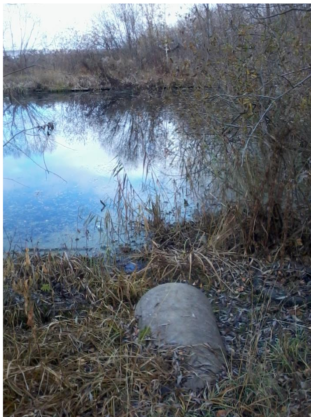
27 pav. Nešienaujami paviršinių nuotekų griovai: Nr.30 ( ties Mechanikų g. - Pirties g. ir ties įtekėjimu į Rėkyvos ežerą).
