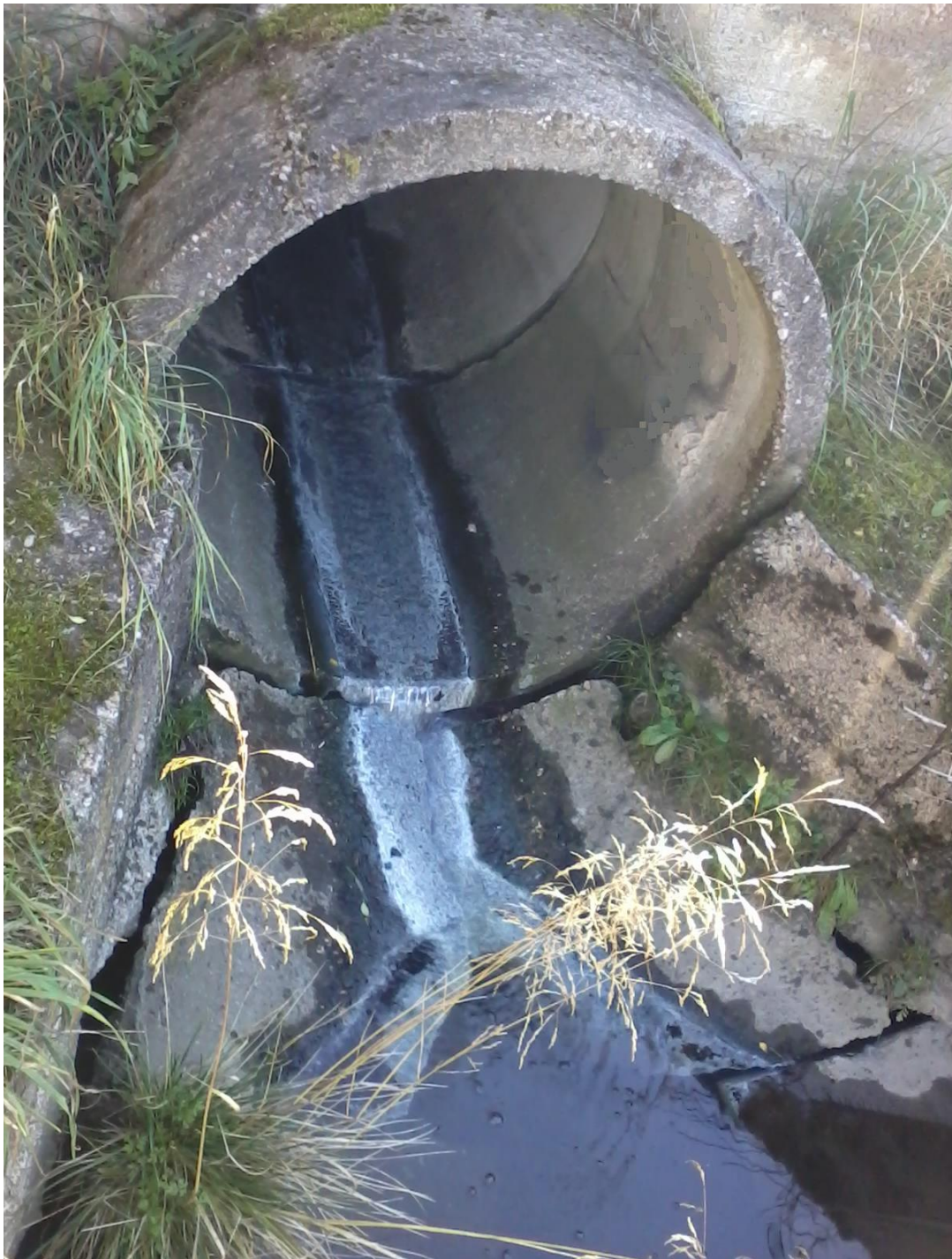
73 pav. Taršos buitinėmis nuotekomis pėdsakai 2015-10-13 d. paviršinių nuotekų išleistuve į Vijolę ties Gumbinės g.
