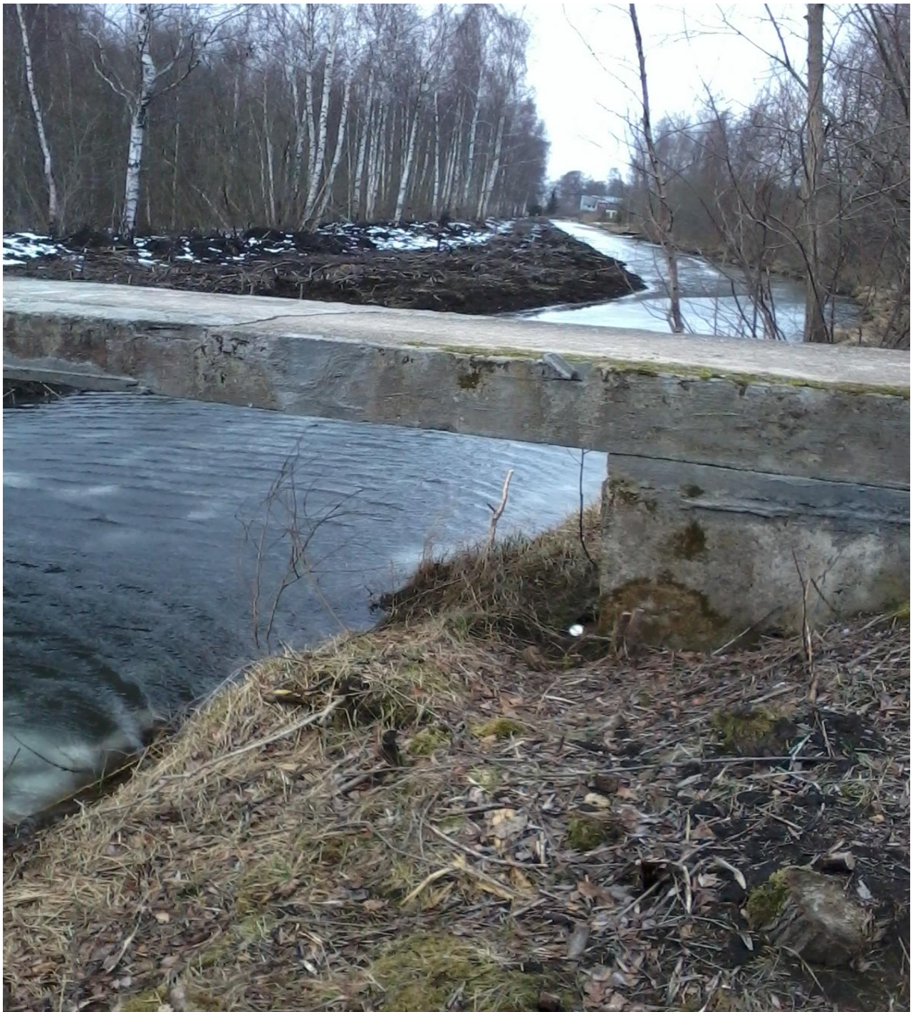
85 pav. Kanalas ties ištekejimu iš Rėkyvos ežero, mėginių paėmimo vieta Nr.1.
