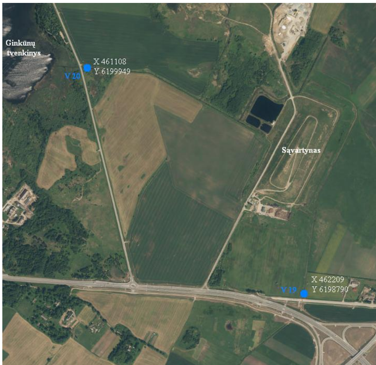
32 pav. Vandens mėginių paėmimo vietos melioracijos griovyje, įtekančiame į Ginkūnų tvenkinį.
