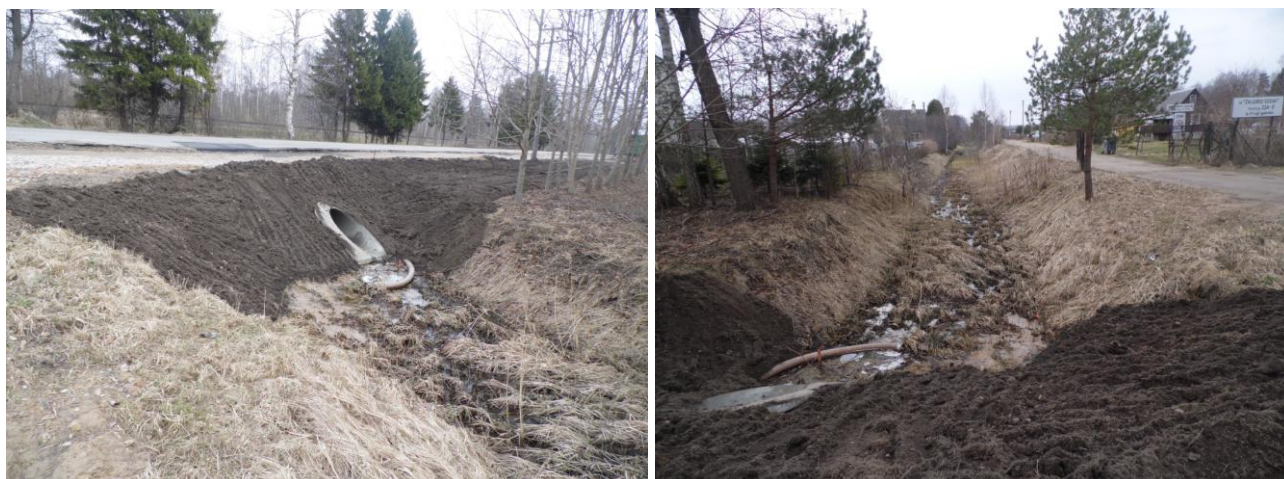
31 pav. Paviršinių nuotekų iš oro uosto teritorijos išleistuvas į Šimšės upelį
