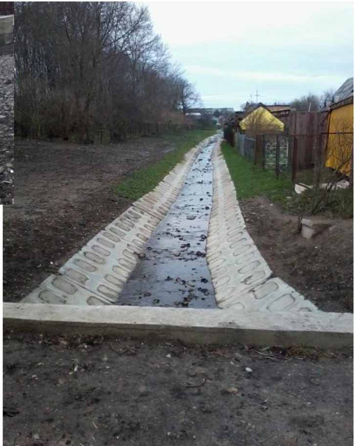
27 pav. Paviršinių nuotekų kanalas nuo Ežero g. iki Talkšos ežero prieš ir po rekonstrukcijos.
